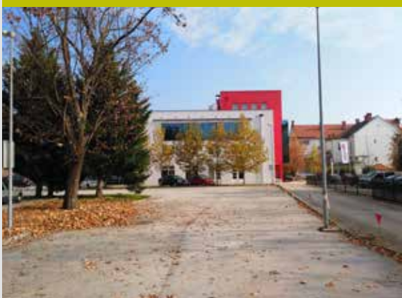
AB GRADNJA KARLOVAC MONTCOGIM PLINARA
